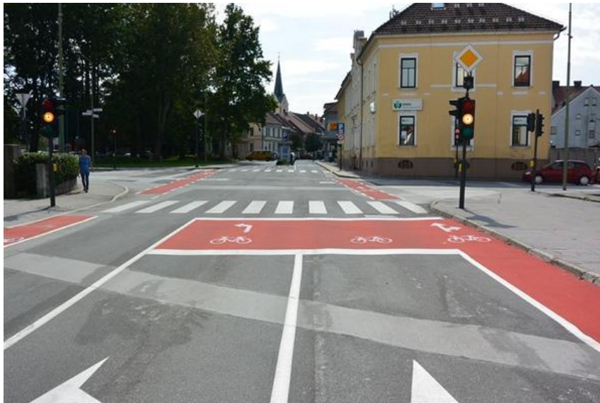
Površina za zaustavljanje biciklista u Slovenj Gradecu u Sloveniji (foto: Mestna občina Slovenj Gradec)
